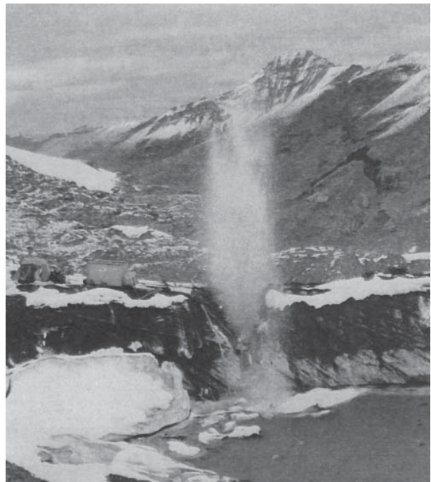
Photo 3.17 : Excavation à l'explosif de la tranchée de vidange artificielle
