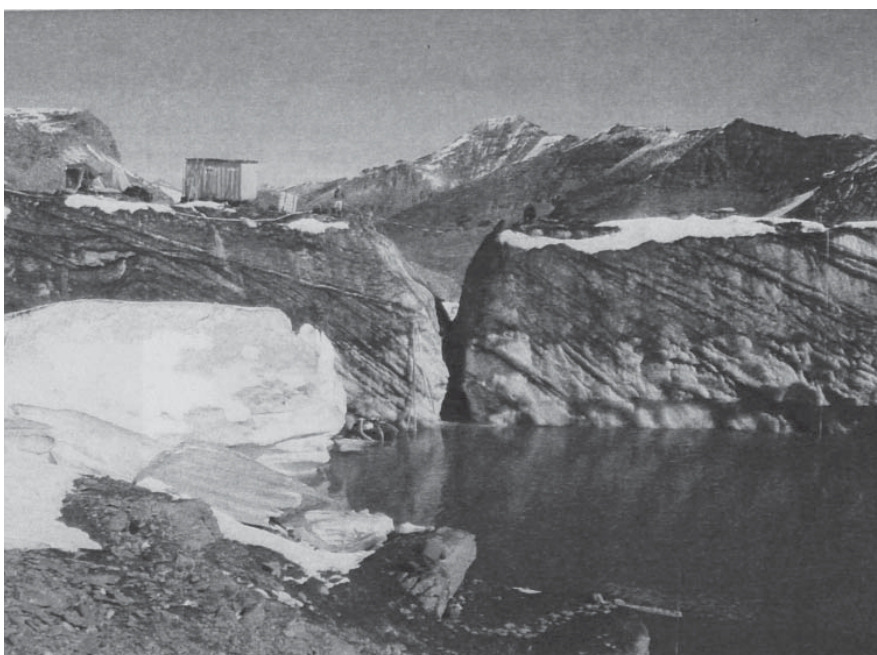
Photo 3.18 : Vue en coupe de la tranchée de vidange artificielle
